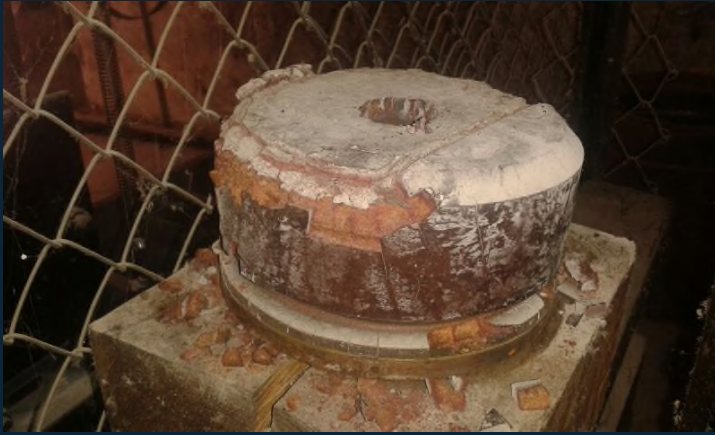
Ausgehärteter Fahrkorb-Puffer erfüllt seinen Zweck nicht mehr
